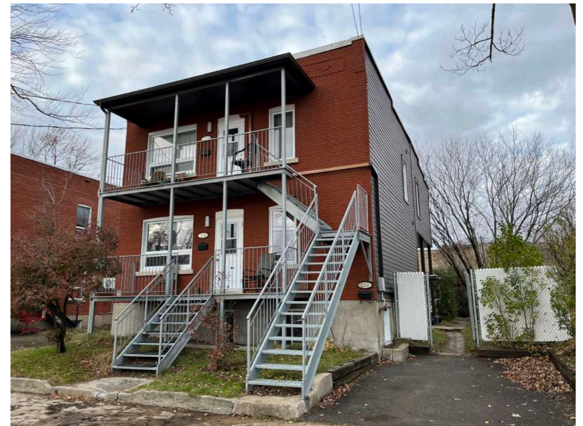
La Maison de Chambre Communautaire du Centre Le Havre et du Réseau d'Habitation Communautaire de la Mauricie (RHCM), est un projet pilote initié depuis avril 2023. La présence de deux intervenants psycho-sociaux permet la stabilisation des résidents dans un petit groupe où collectif et individuel trouvent un compromis...
